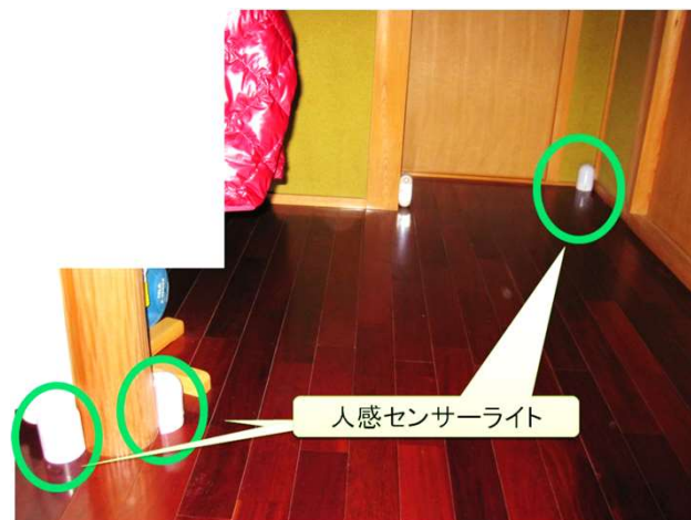
人感センサーライトを設置した状態
