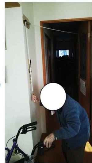
開き戸を締めるのに方向転換をして戻って締めていましたが、ロープを下方へ引っ張れば扉が締められます。
